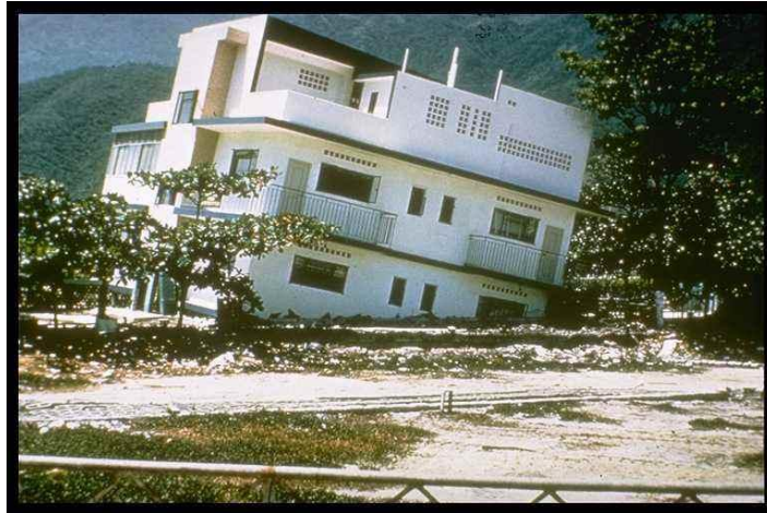
Photo 1-1 : Effet de liquéfaction « séisme de Caracas (Venezuela) en 1967 » 41
